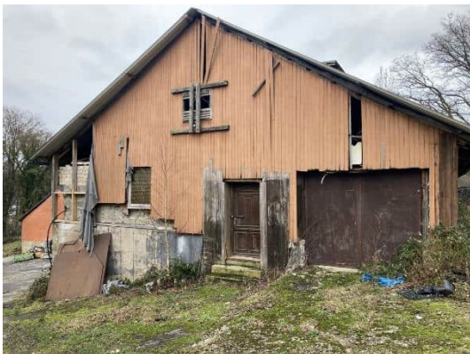
Abb. 11 Lagerhalle im Plangebiet.
